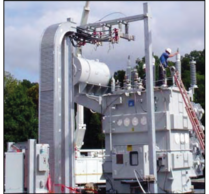
MP Husky 4000Amp, 5kV Kablo Bus sistemi, GSU trafo için açık hava sonlandırması ile.
